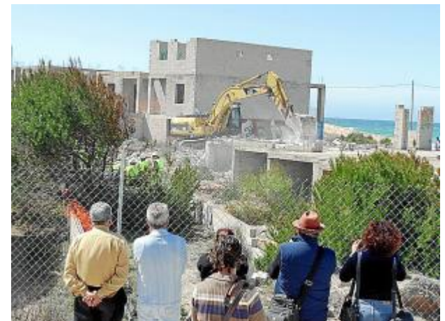
За сносом наблюдают уполномоченные от совета острова и городского строительного агентства. Фото: М.А.С./G.M.
