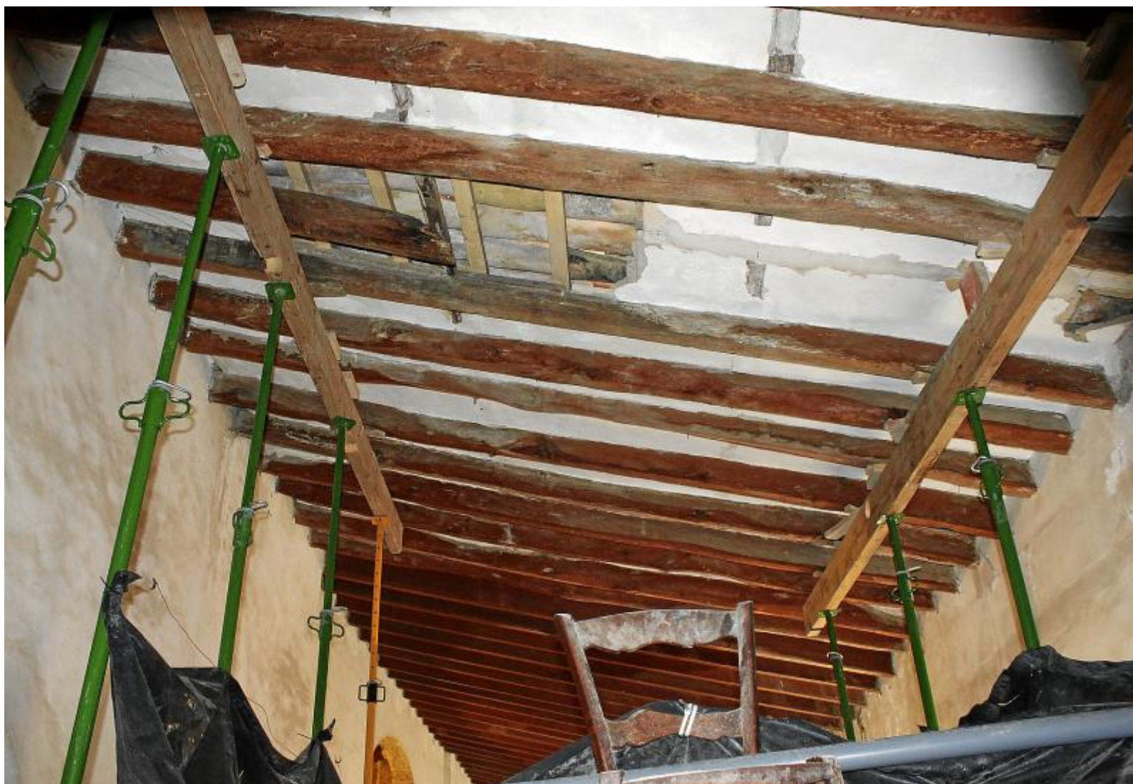
Ремонтные работы зависят от степени поражения: удаление и очистка, покраска подвергшихся налёту поверхностей, вплоть до замены поражённых элементов
